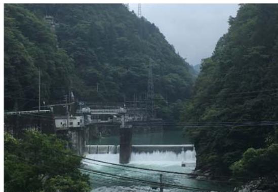
祖谷川にある6箇所の水力発電所 大正元年から建設（三縄発電所から）
